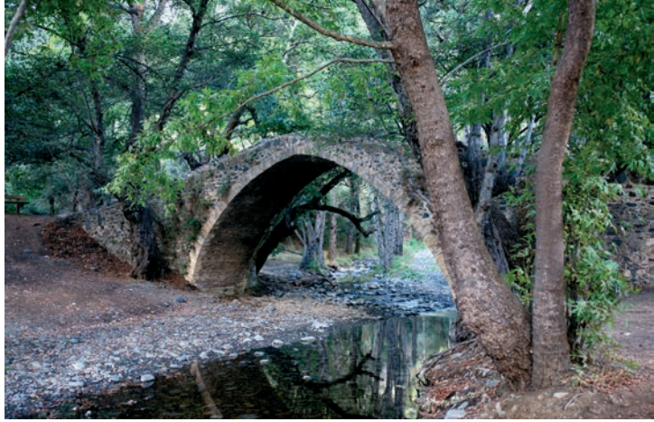
Pont de Tzelefos
