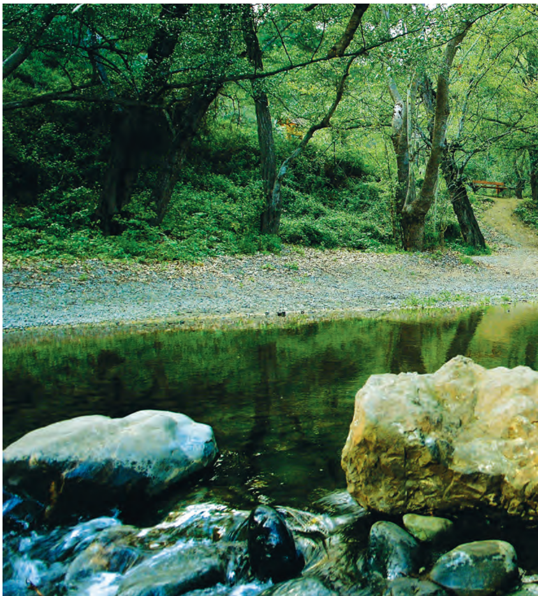
▲ Το Ενετικό γεφύρι του Τζελεφού, στον ποταμό Διάριζο.
