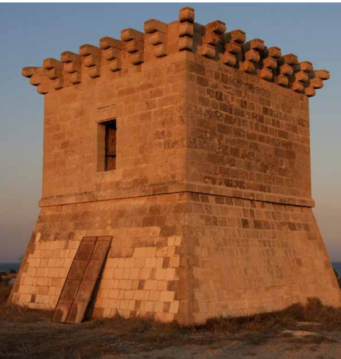
Fig.29 Torre di avvistamento veneziana, nei pressi del villaggio di Kiti
