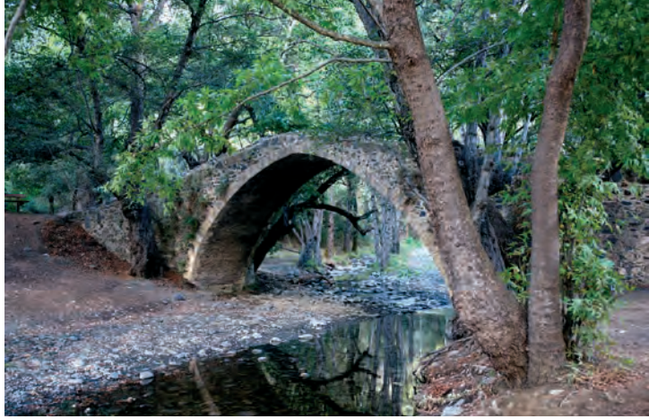
Pont de Tzelefos
